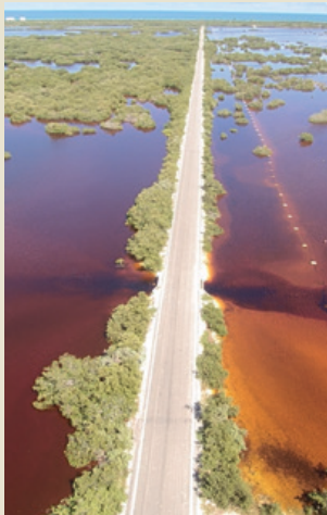
Figura 2.17 – Rehabilitación de pasos de agua para restablecer el flujo de agua en sitios afectados por la construcción de caminos. Elaboró Oscar Pérez, Andrés Canul y Diana J. Cisneros.
