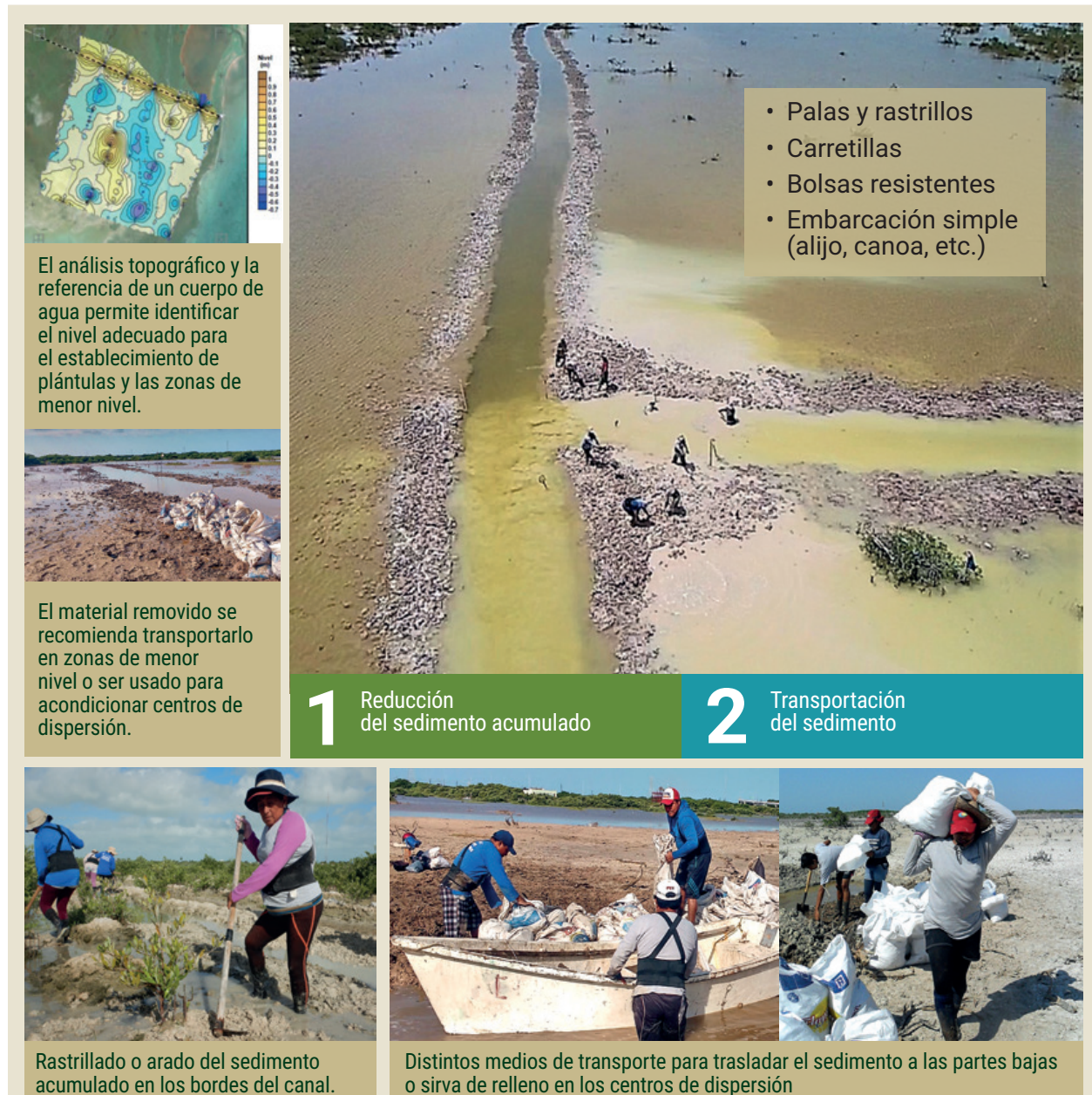
Figura 2.19 – Recomendaciones y pasos para la remoción de sedimento para la rehabilitación topográfica en la restauración ecológica de manglar. Elaboró Oscar Pérez, Andrés Canul y Diana J. Cisneros.
