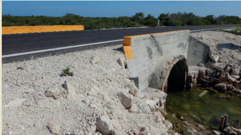
Paso de agua obstruido por escombros
