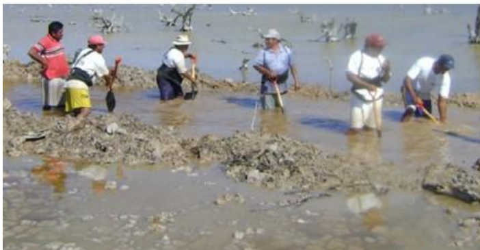
Habilitación de canales nuevos
