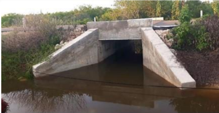
Desasolve de pasos de agua
