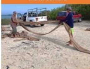
Instalación de CD en zonas inundadas
