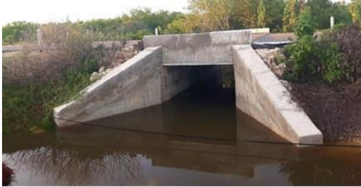
Desasolve de pasos de agua
